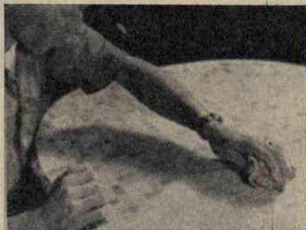
Fig. 10 - Per raggiungere un maggior effetto estetico, coleremo negli interstizi esistenti fra piastrella e piastrella colla a presa lenta, alla quale sia stato aggiunto preventivamente colore in polvere. Gli eccessi di colla verranno eliminati con l'ausilio di un cencio inumidito in acqua.
